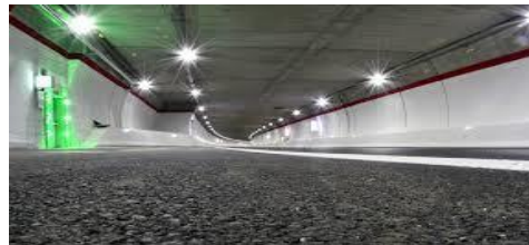
Sistema Telecontrollo Impianti
